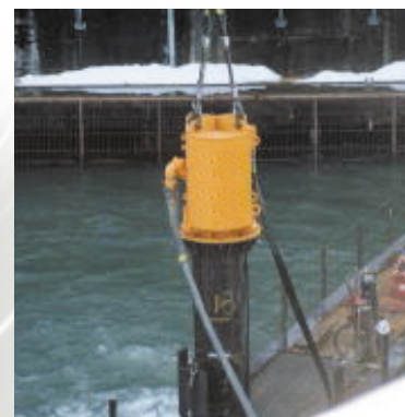
HO-5800による岩盤削孔
